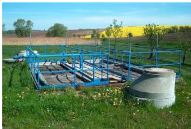
Obr. 3 Štěrbínová usazovací nádrž ČOV Dražovice
