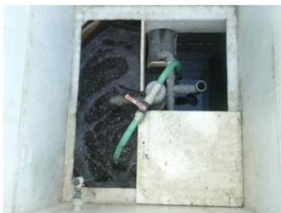
Obr. 2 Pohled do balené aktivační ČOV pro 4 EO
