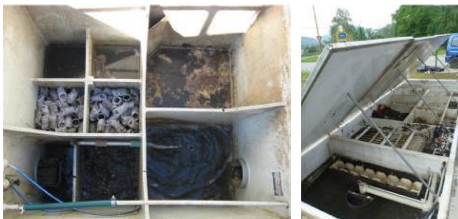
Obr. 1 Pohled na jednotlivé sekce anaerobně-aerobních ČOV (vlevo pro 5 EO, vpravo pro 200 EO)
