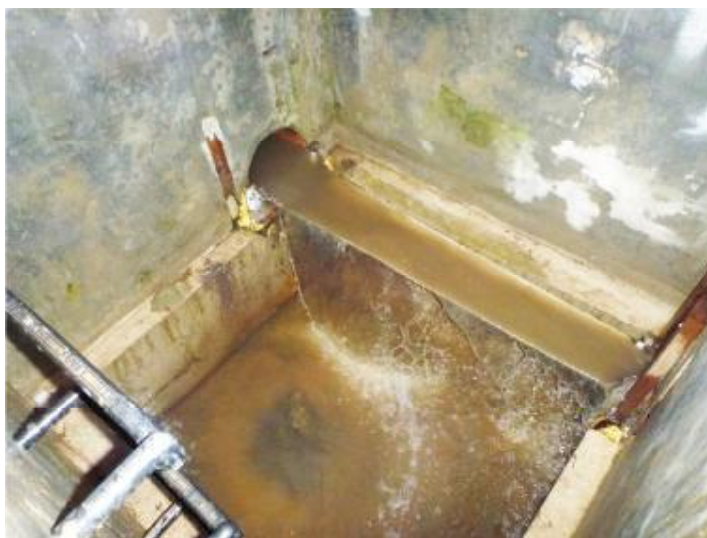
Obr. 5 Částečně zrekonstruovaná odlehčovací komora s využitím zužujícího se žlabu (bez rozrážecí radlice a regulujícího ovladače)
