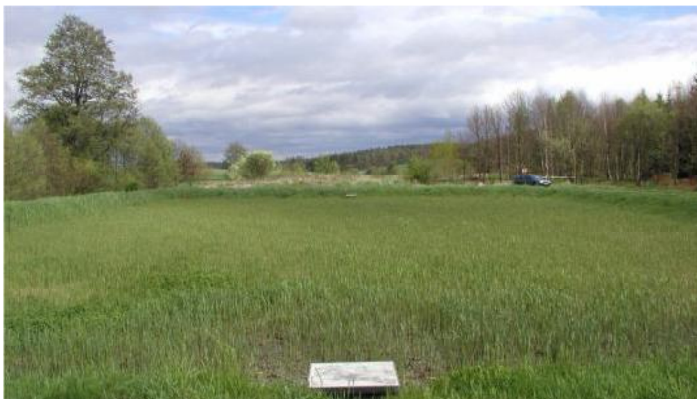
Obr. 1. Kořenová čistírna odpadních vod Kotečnice, rok výstavby 1994, jeden horizontální kořenový filtr osazený rákosem obecným. Na obrázku situace v květnu 2005.
