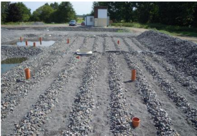
Obr. 6. Vertikální kořenový filtr Tok D - KČOV Kotenčice (září 2012).
