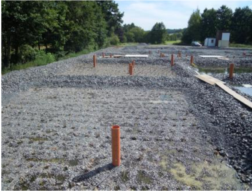
Obr. 5. Horizontální kořenový filtr Tok A - KČOV Kotenčice (září 2012).
