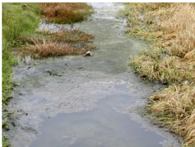
Obr. 3 Kolmatace filtračního prostředí odumřelou vegetací z rozdělovacího příkopu
