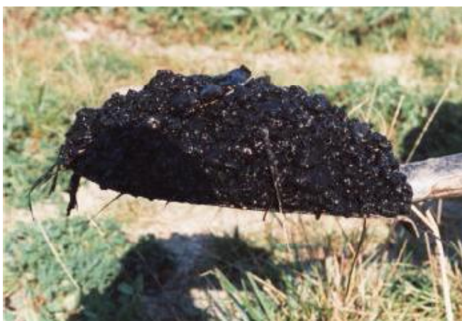
Obr.2 Silně zakolmatovaný filtrační materiál vegetační kořenové čistírny
