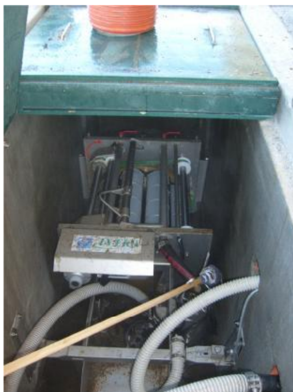
Obr. 2 Bubnový mikrosítový filtr
