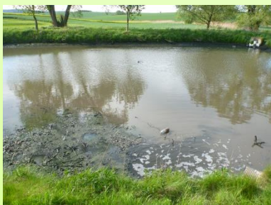
Pohled na stabilizační nádrž pro 750 EO
